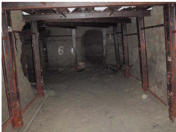
通常時 第3坑道の状況②(平成23年5月)
