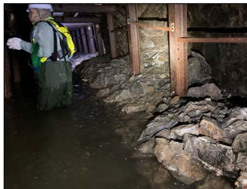
④ 第2坑道の湛水状況
