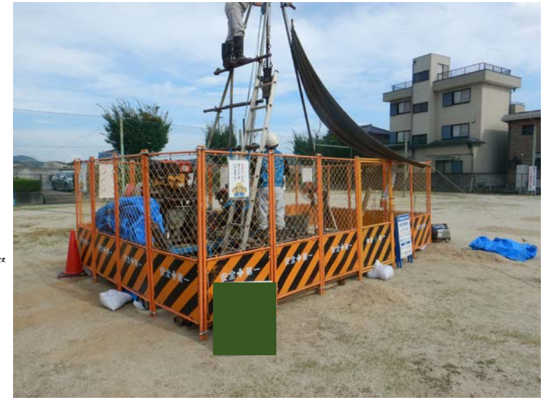
ボーリング調査 (参考事例)
