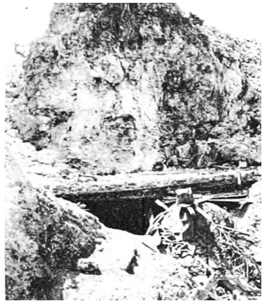
Figure9 シャフトA 地上入口
