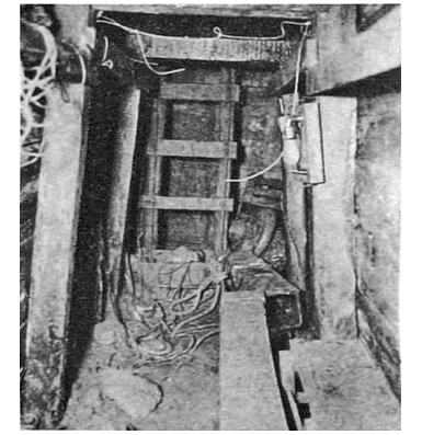
Figure12 シャフトA内部
