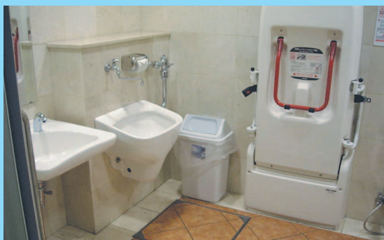
オストメイト対応トイレ（3店舗に整備）
