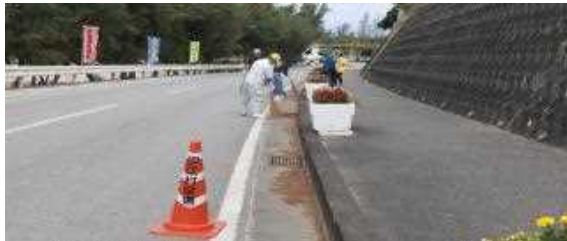
道路の清掃作業
