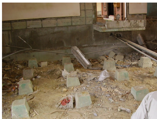
図 2. 本島中部建築物解体現場
