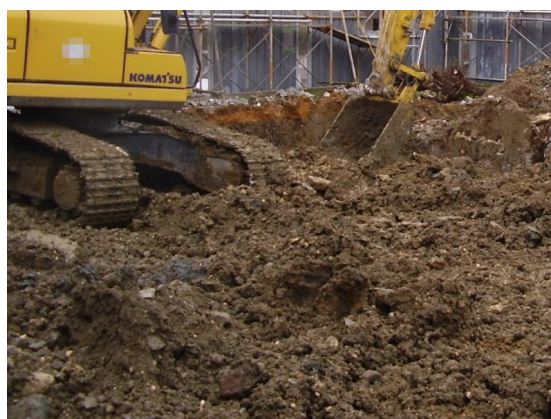
図 4. 本島南部建築物解体現場②
