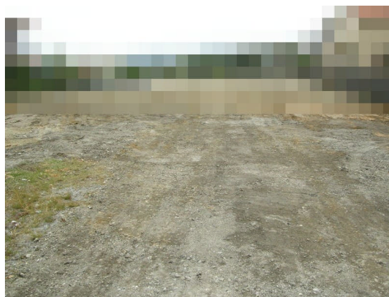
図 1. 本島北部建築物解体現場
