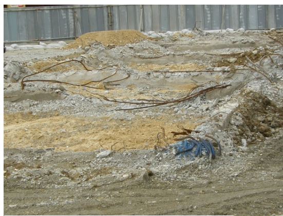
図 3. 本島南部建築物解体現場①
