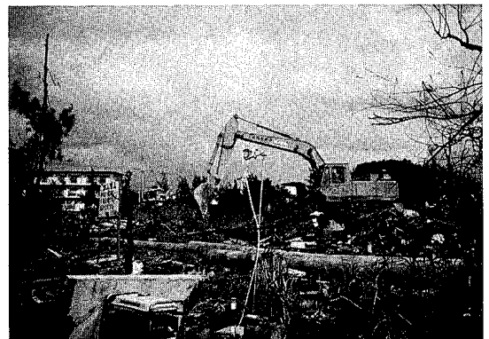
写真1 撤去作業風景
