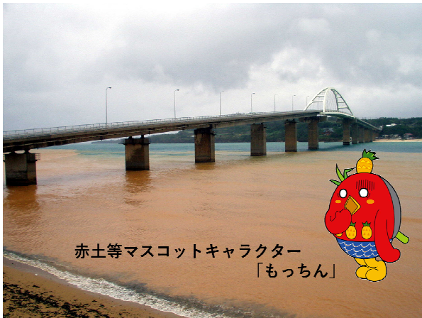
図 2. 赤土等が流出している様子(本部町瀬底大橋:本部半島側から撮影)
