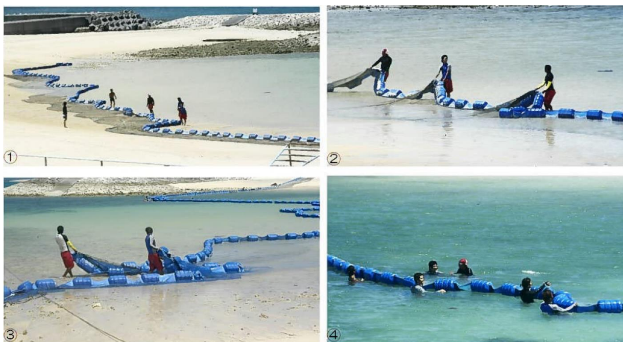
写真4. ネットを着底して、設置位置まで移動する様子（設置法3）
