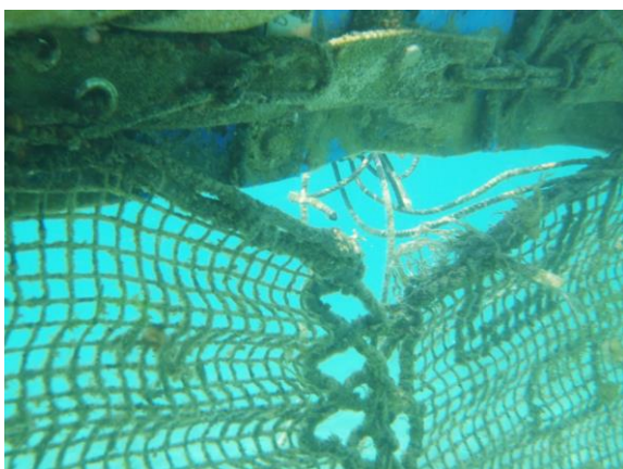
つなぎ目のロープがほどけ、隙間がある
