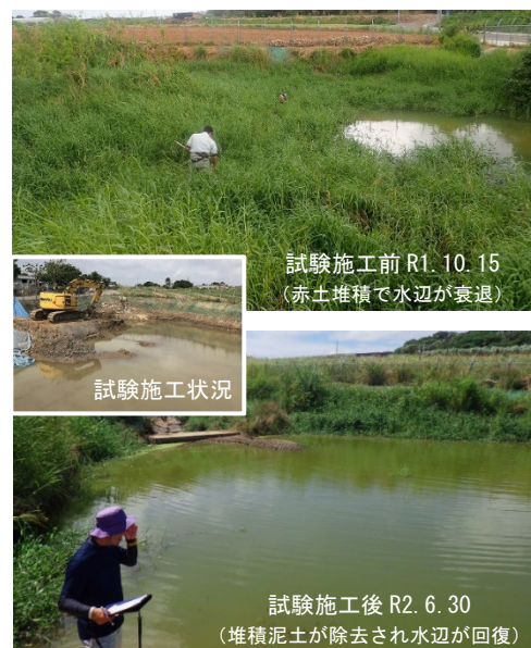
図-3 試験施工沈砂池の様子（R1-2）
