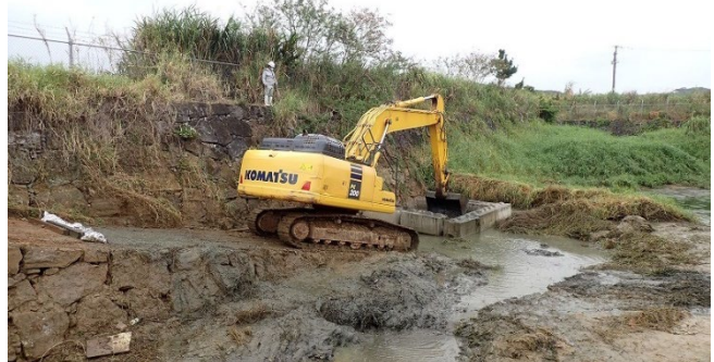
図-1 堆積泥土改良試験施工の様子
