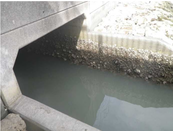
No-①地点直上の暗渠
