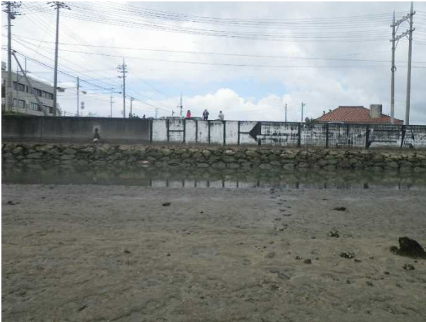
No-②地点状況(対岸側から)
