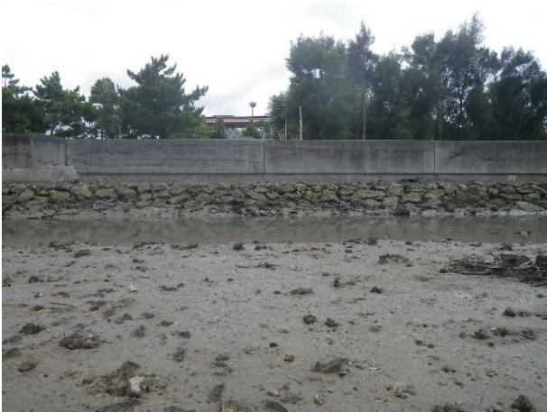
No-⑦地点状況(南方向)
