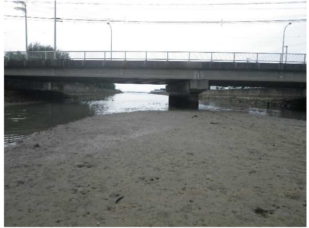
No-⑤ 地点状況(下流側)
