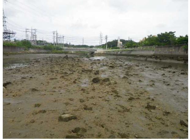
No-⑦ 地点状況(上流方向)
