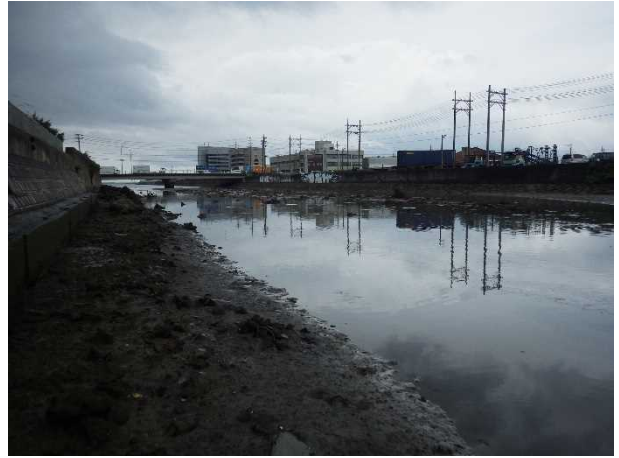
No-⑧ 地点状況(下流方向)
