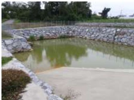
写真 3-1 沈砂池
