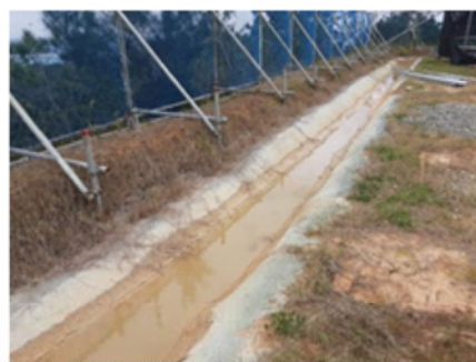
写真6 場内仮設排水路
