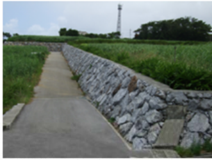
写真1 勾配抑制(土木的対策)
