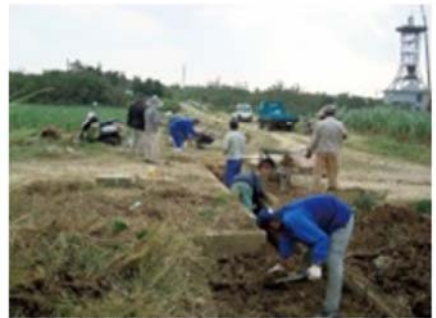
写真8 排水路や土砂溜樹の泥上げ(営農的対策)
