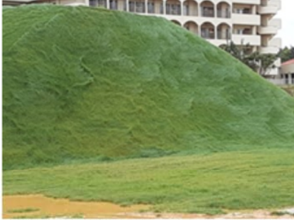
写真1 土壤団粒化剤+種子吹付
