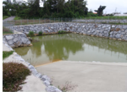
写真2 沈砂池(土木的対策)
