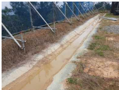
写真14 場内仮設排水路
