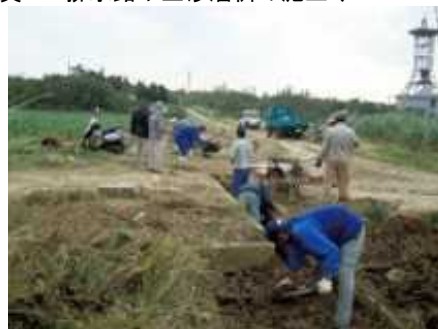
写真8 排水路や土砂溜樹の泥上げ
