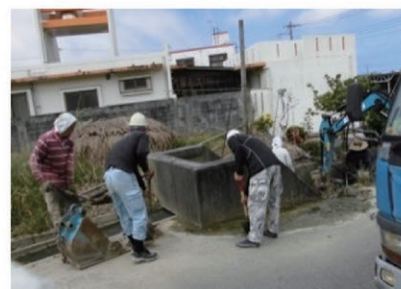
排水路の泥上げ
