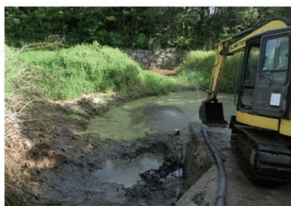
沈砂池の泥上げ
