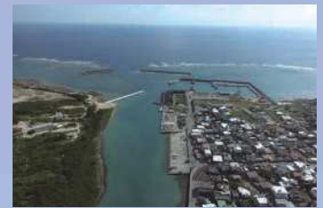
港川漁港(八重瀬町)
