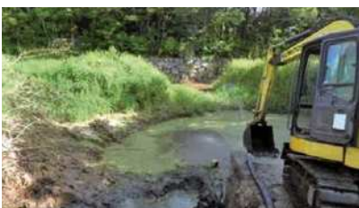
沈砂池の泥上げ
