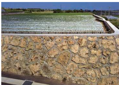
真栄平地区（勾配抑制工）
