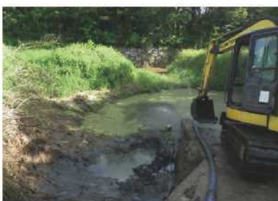
沈砂池の泥上げ
