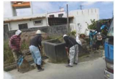
排水路の泥上げ
