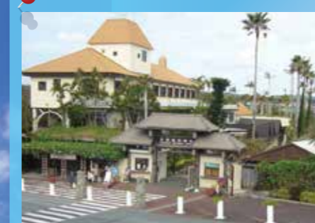
(LED照明+高効率ポンプ) 東南植物楽園
