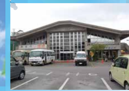
(LED照明+高効率空調+BEMS)北谷スポーツセンター
