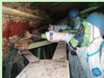
吹付け石綿の除去作業の様子
