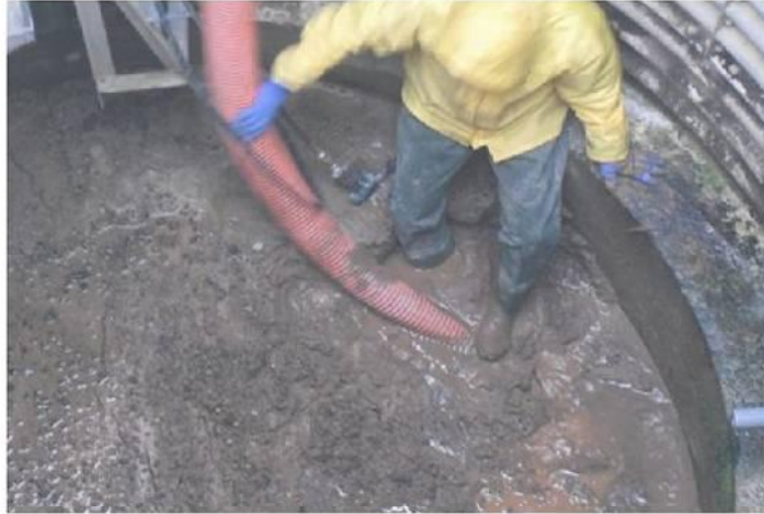
写真 3.3-4 バキュームによる吸引除去のイメージ
