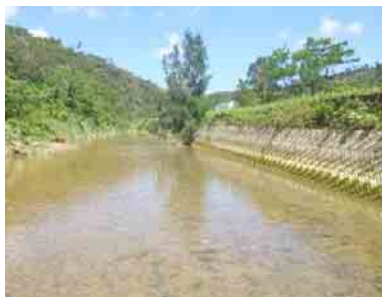
河川改修による河道の直線化
