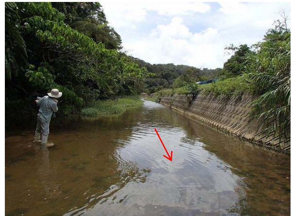
下流域：高い護岸と河道の直線化
