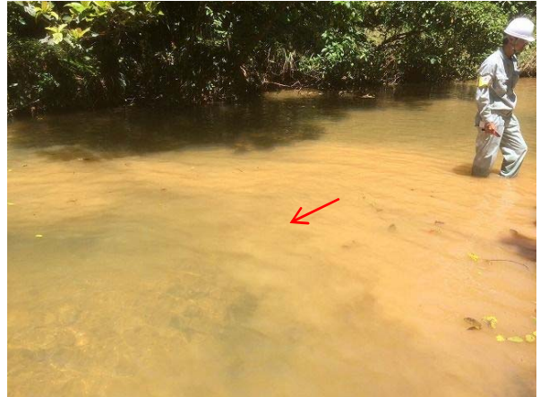
溪流取水施設への赤土・土砂の堆積
