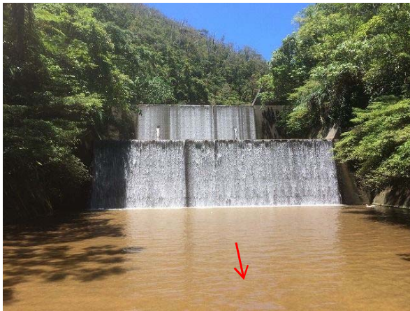
砂防ダム：上流側
