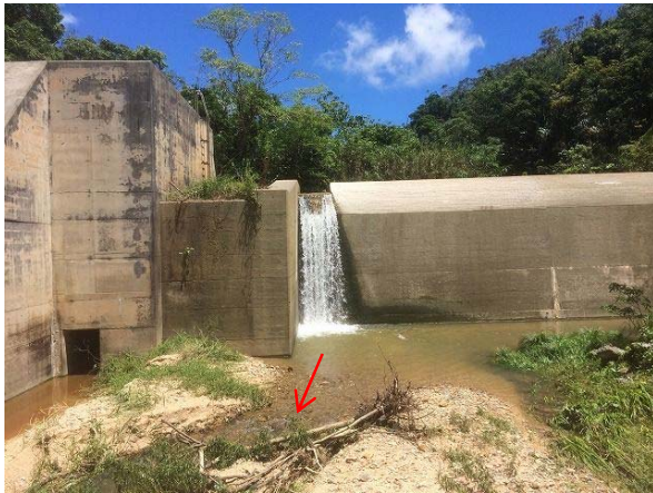
溪流取水施設
