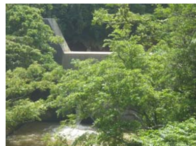
写真 砂防施設
