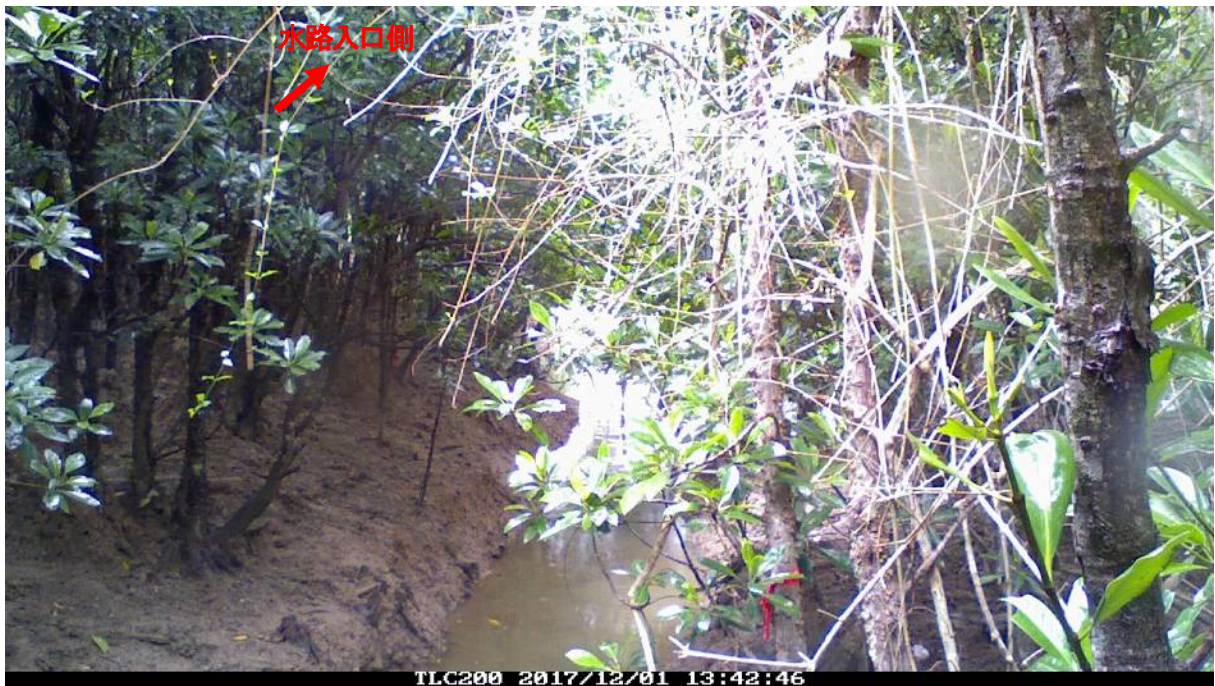
掘削後 (平均潮位(潮位 115cm)時)
