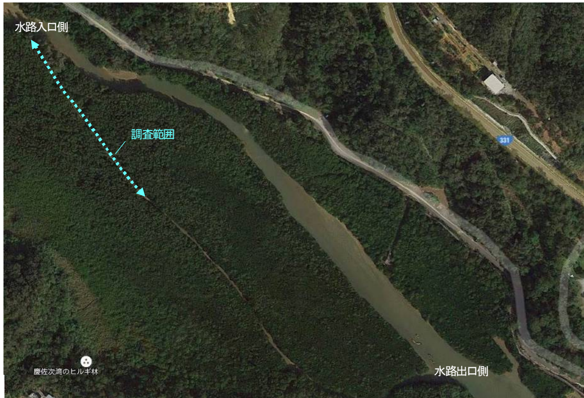
図 1.2.4-5 モニタリング調査地点
