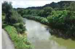
工事前の下流域の現状
