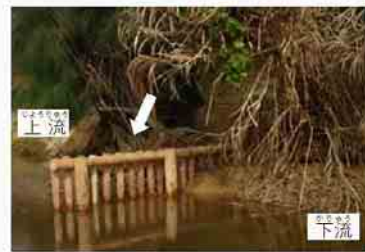
ワンドの深みを維持するための水制工
