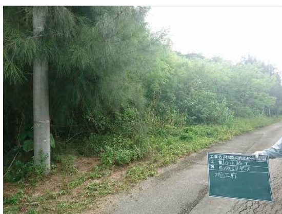
写真 1.2.1-6 仮設ヤード整備前状況
