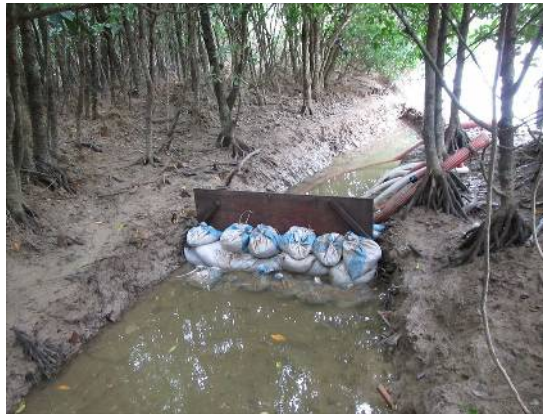
写真 1.2.2-2 本川への濁水流出防止対策として設けた止水壁
