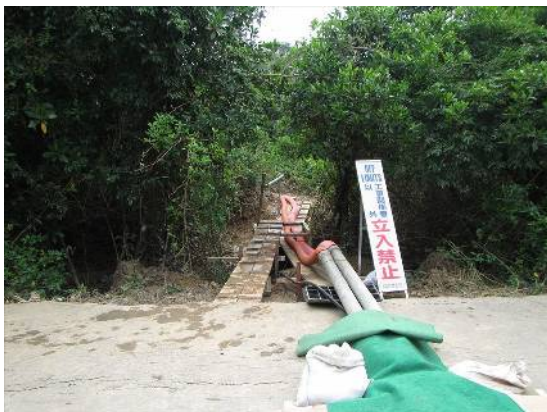
写真 1.2.1-4 工事進入路整備状況
