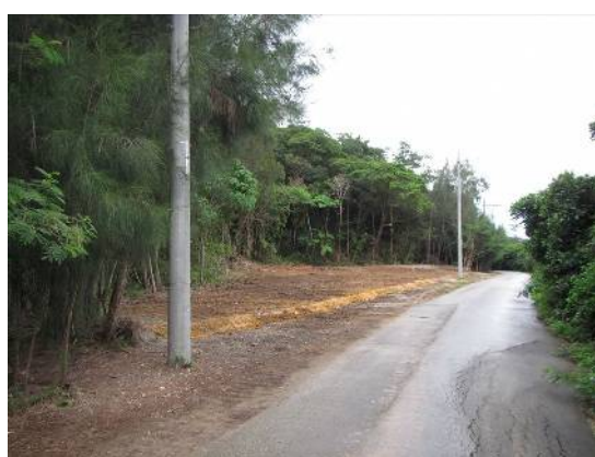
写真 1.2.1-9 仮設ヤード復旧後の状況
