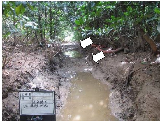
写真 1.2.2-1 小水路掘削時の仕切り作業の状況（白抜き矢印が仕切り土堤）
