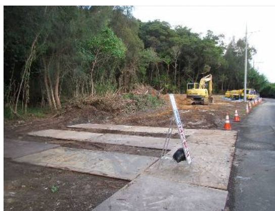
写真 1.2.1-7 仮設ヤード整備状況
