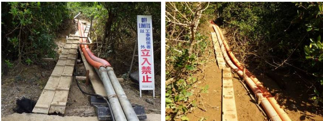
写真 1.2.2-6 移動経路における板の敷設状況
