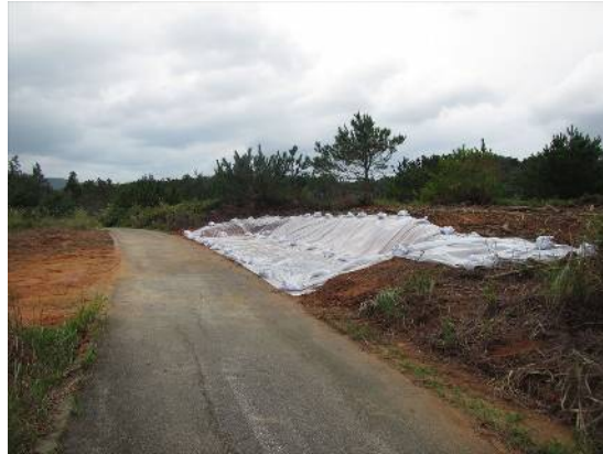
写真 1.2.1-11 土砂処分場復旧後の状況
