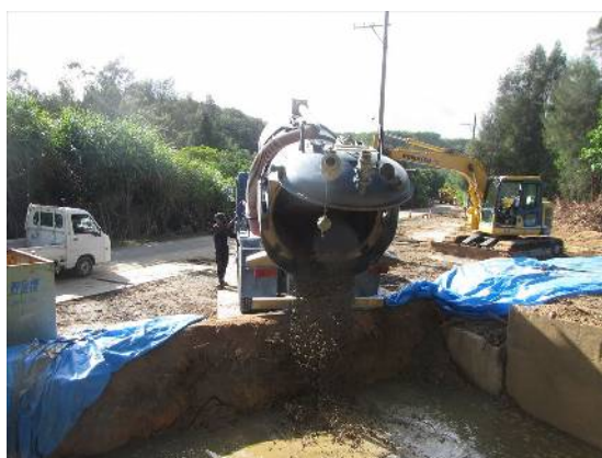
写真 1.2.1-8 釜場への掘削土砂排出状況
