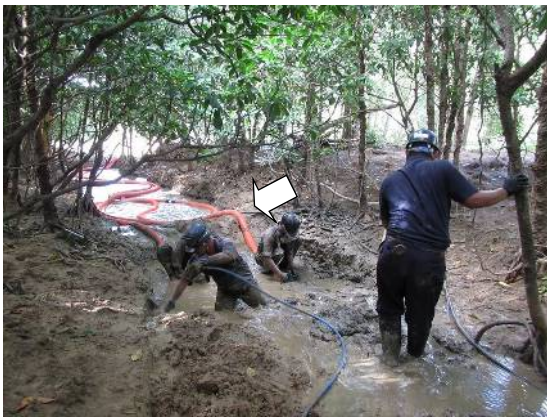
写真 1.2.2-1 小水路掘削時の仕切り作業の状況（白抜き矢印が仕切り土堤）
