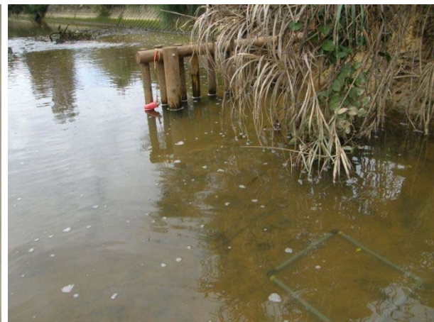
水制工後。設置直後のため水制工前後で大きな変化はない
