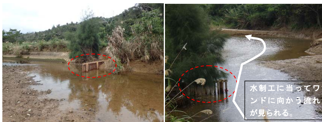
図 1.3.2-10 整備した水制工
