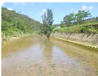
河川改修による河道の直線化
