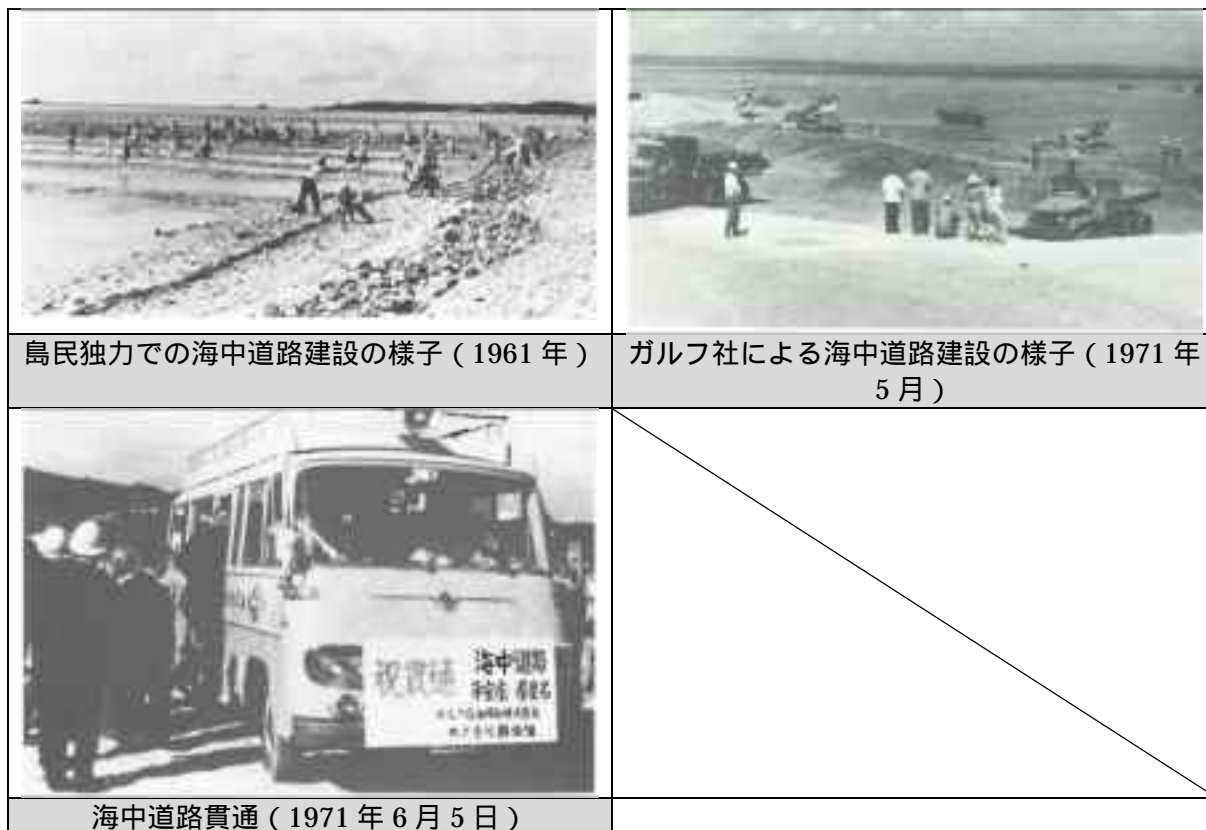
写真 1.3.2 ガルフ社による海中道路建設
