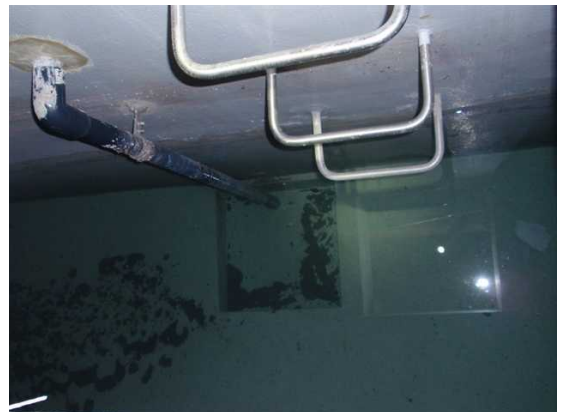
雨水貯留槽内部
