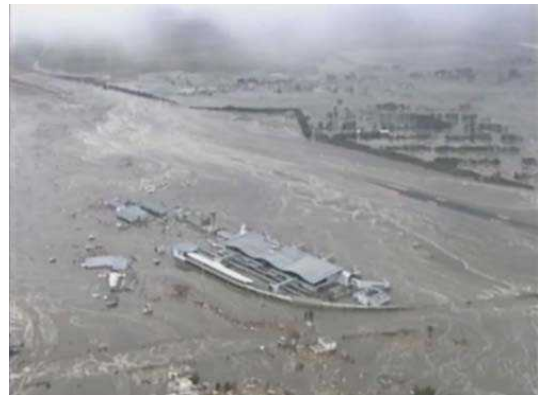
津波直後の仙台空港の状況
