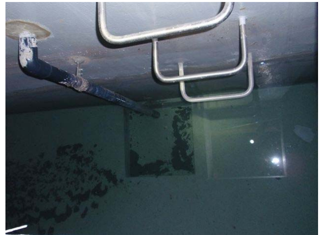
雨水貯留槽内部
