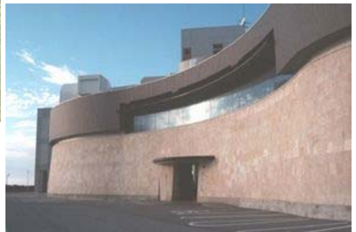
沖縄県企業局海水淡水化センター（北谷町）
