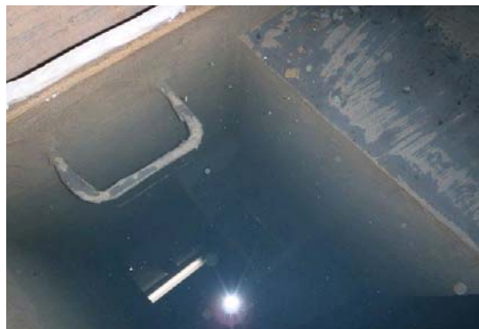
沈殿槽の例（西原小学校）
