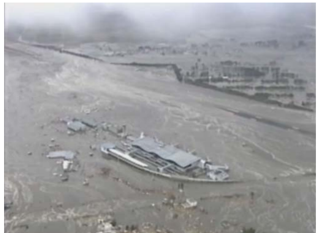
津波直後の仙台空港の状況
