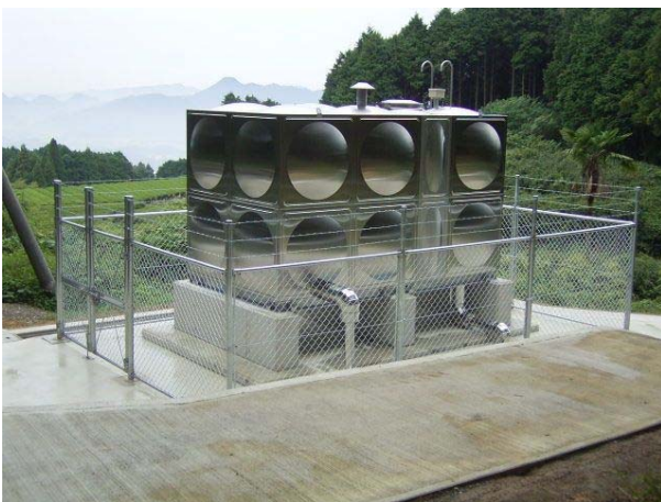
地上設置タイプ（ステンレス製）
