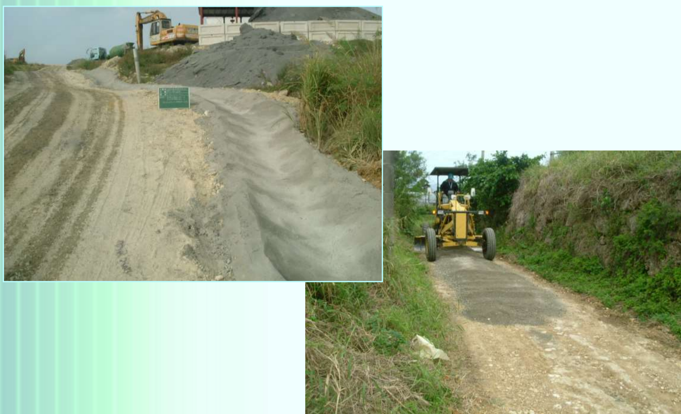
造粒物の路盤材としての試験施工
