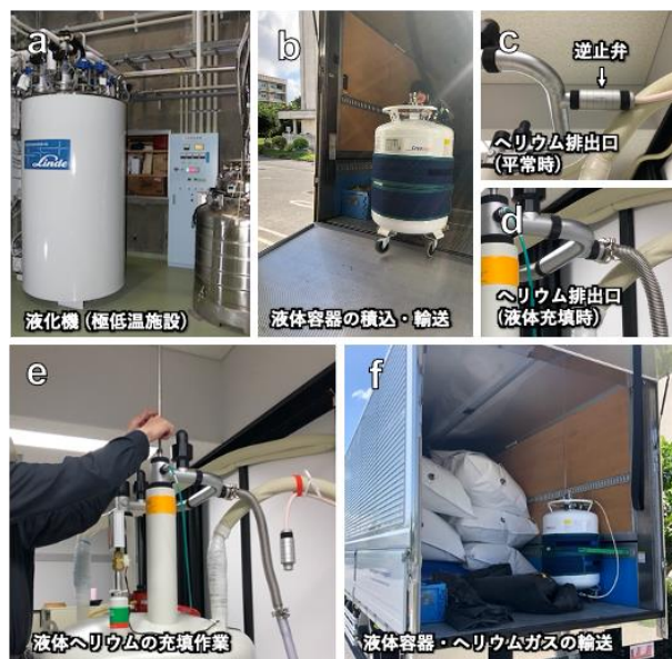
図5 液化ヘリウム充填時のガス回収
