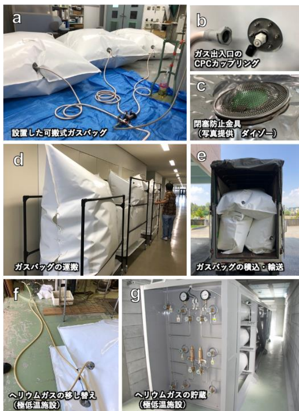
図4 平常時のヘリウムガス回収
