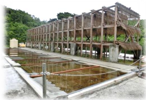
流下式塩田 (自然エネルギーを利用した海水濃縮)
