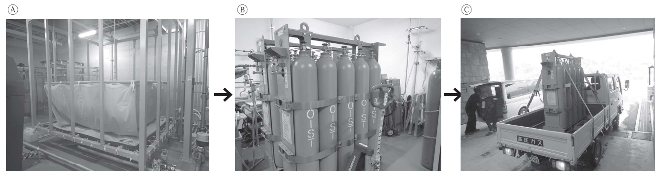
Heガスはガスバッグに回収後圧縮機で容器に充填される。充填後の容器はトラックで琉大へ送られる
